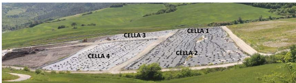
Figura 3 – Vista delle quattro celle centrali della discarica coperte con telo in LDPE
