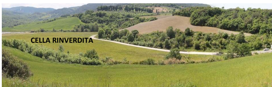
Figura 2 – Prima cella impermeabilizzata definitivamente
